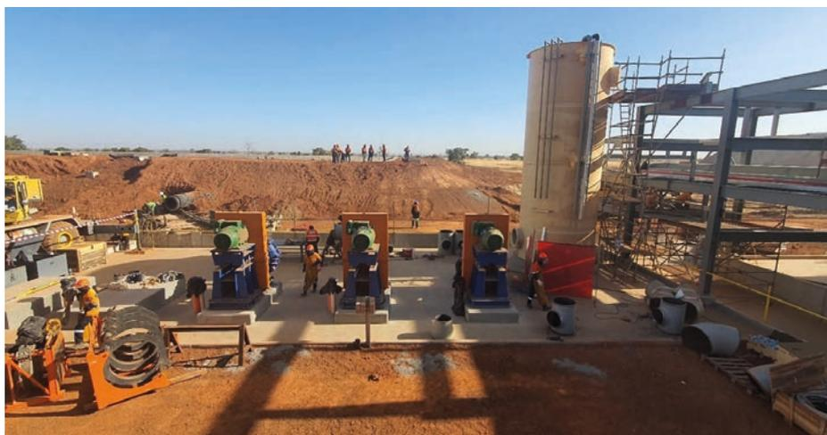
*Zone de traitement d'eau avec piperack4, supports pour porter les tuyauteries de l'unité de production*
