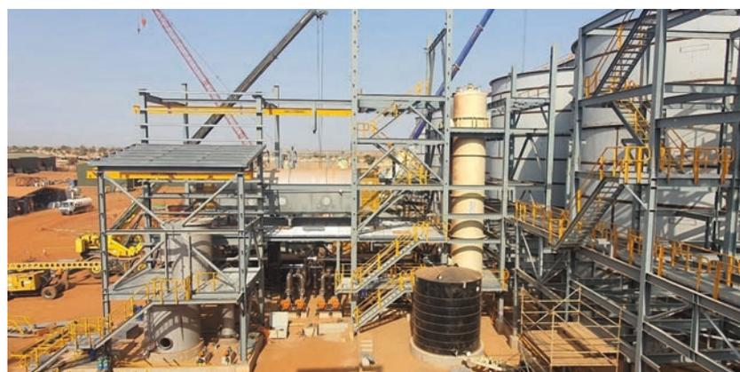
*Côté Est de la zone d'éluion avec le piperack2 supports pour porter les tuyauteries de l'unité de production*
