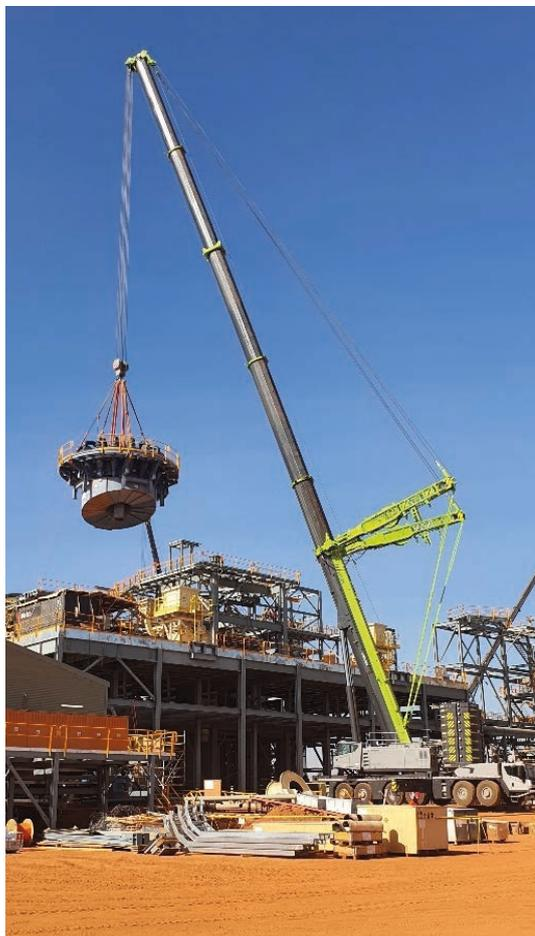
*Côté Nord de la zone de broyage avec installation de cyclone*
