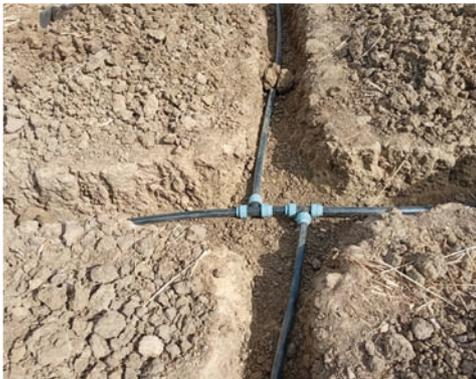
Pose de la tuyauterie de raccordement du château d'eau au bassin
