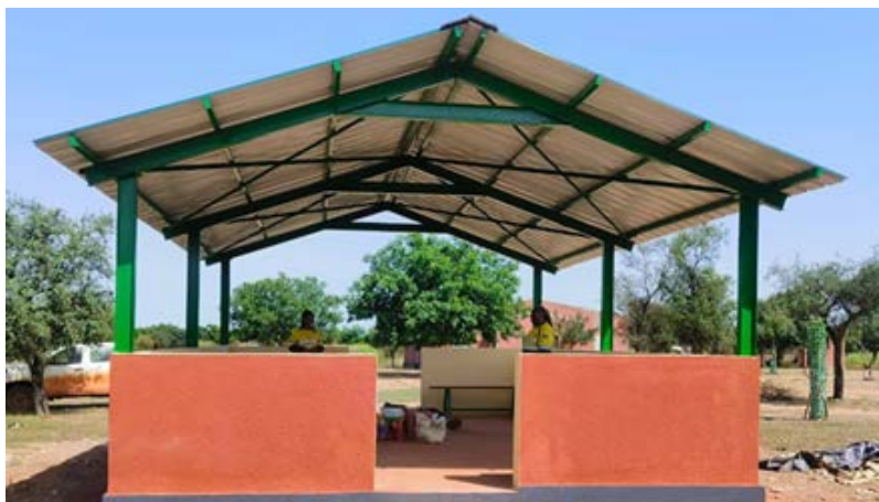
Construction du hangar du centre de santé de Pousshin
