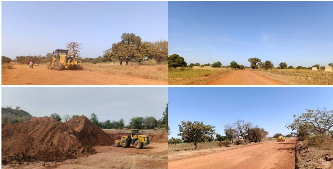
Suivi des travaux de réhabilitation de la route d'accès principale
